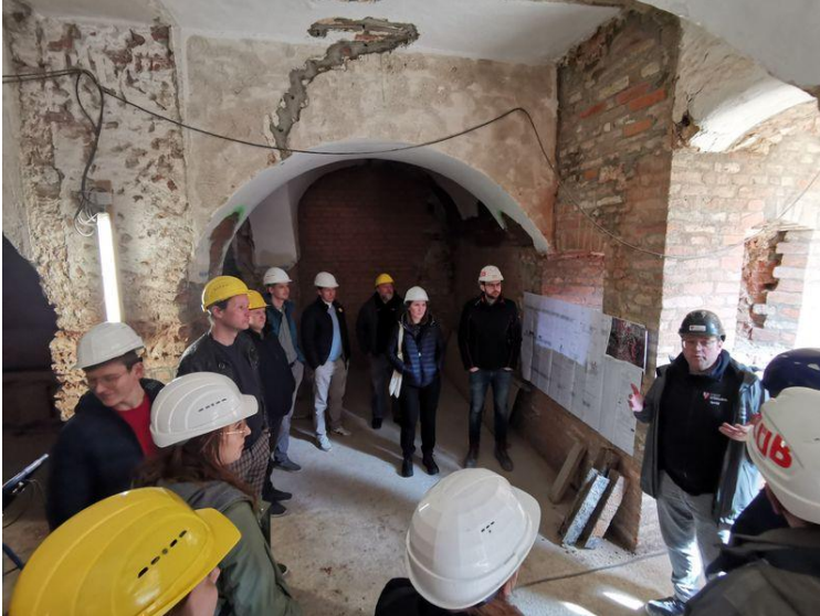
Abb.: Die Jungen Kollegen im historischen Gewölbeingang im Erdgeschoss, welcher derzeit instandgesetzt wird
