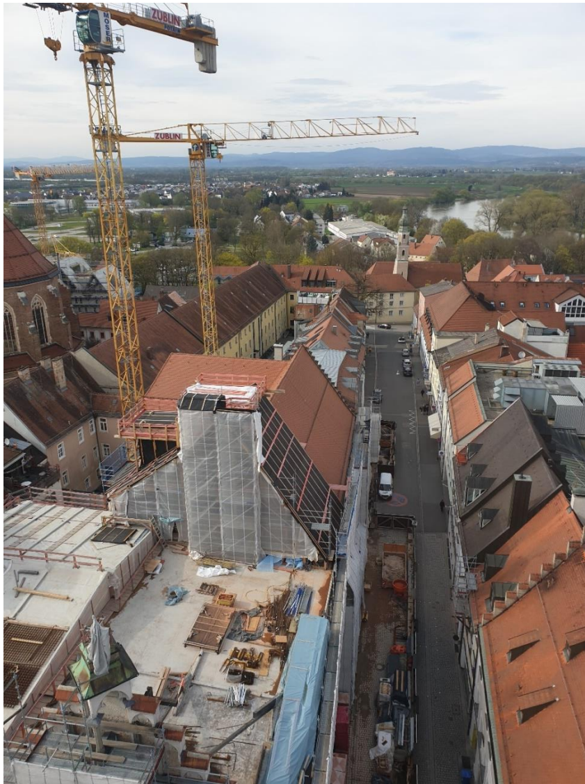
Abb.: Blick vom Straubinger Stadtturm auf die Baustelle des historischen Rathauses im Wiederaufbau und der Donau im Hintergrund
