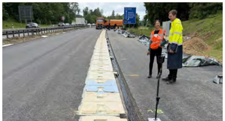
Inspektion der neuen Spulentypen ohne Kondensatorkasten
