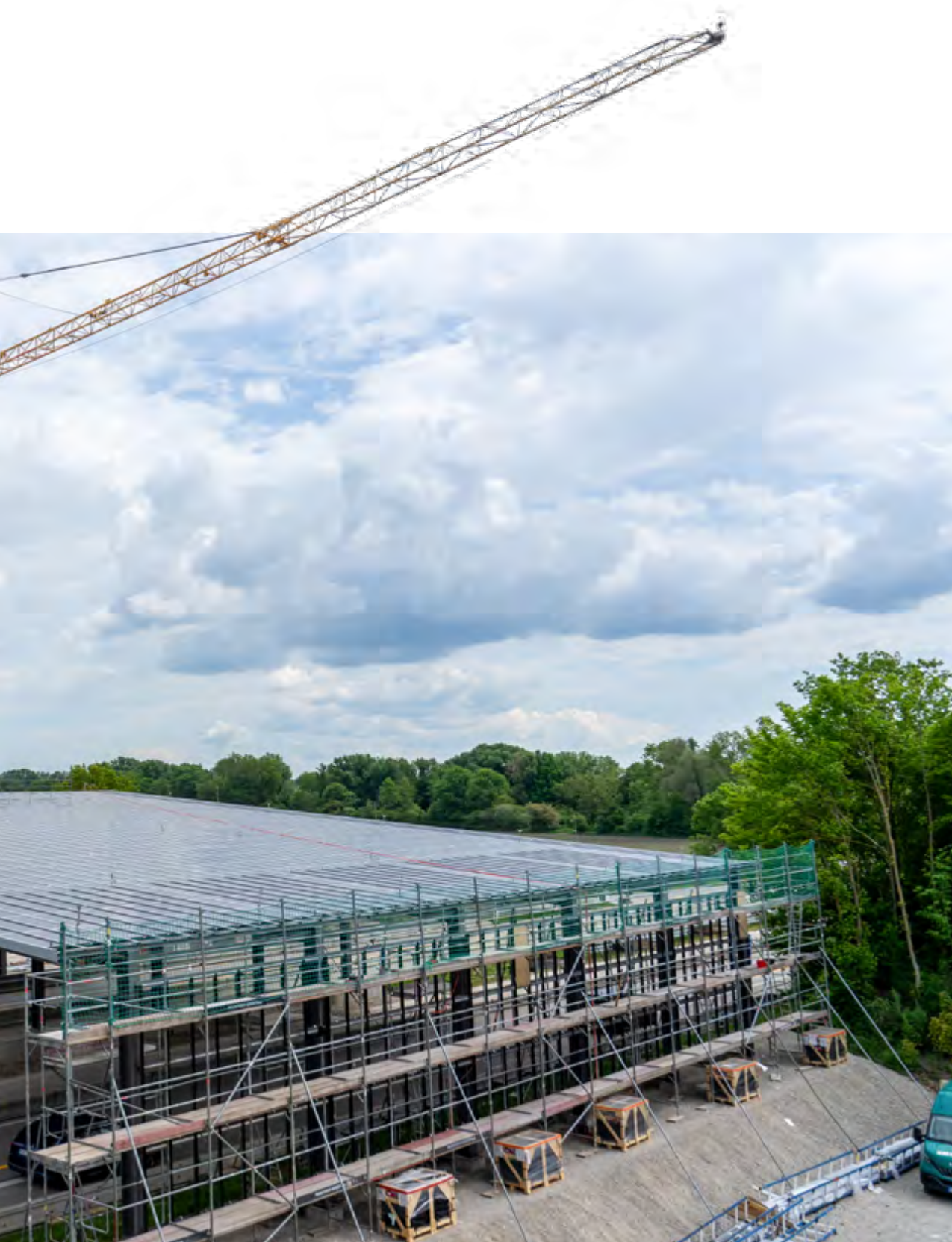
Photovoltaiküberdachung mit Gerüst an der Staatsstraße 2584 westlich des Münchner Flughafens
