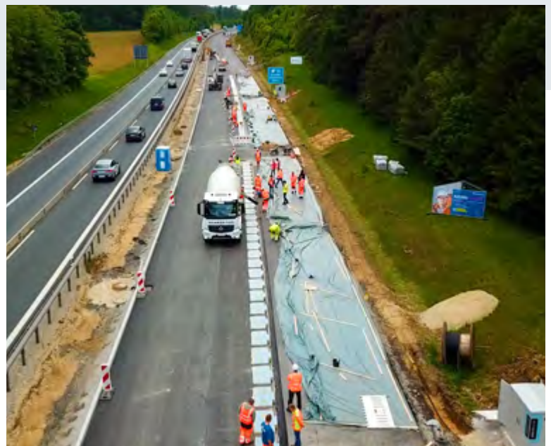
Lage der Spulen in der Fahrbahn
