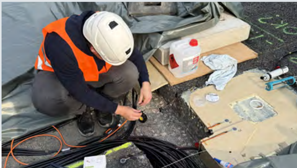
Einbau von Drucksensoren sowie Sensorik zur Erfassung der Temperatur beim Einbau und Betrieb
