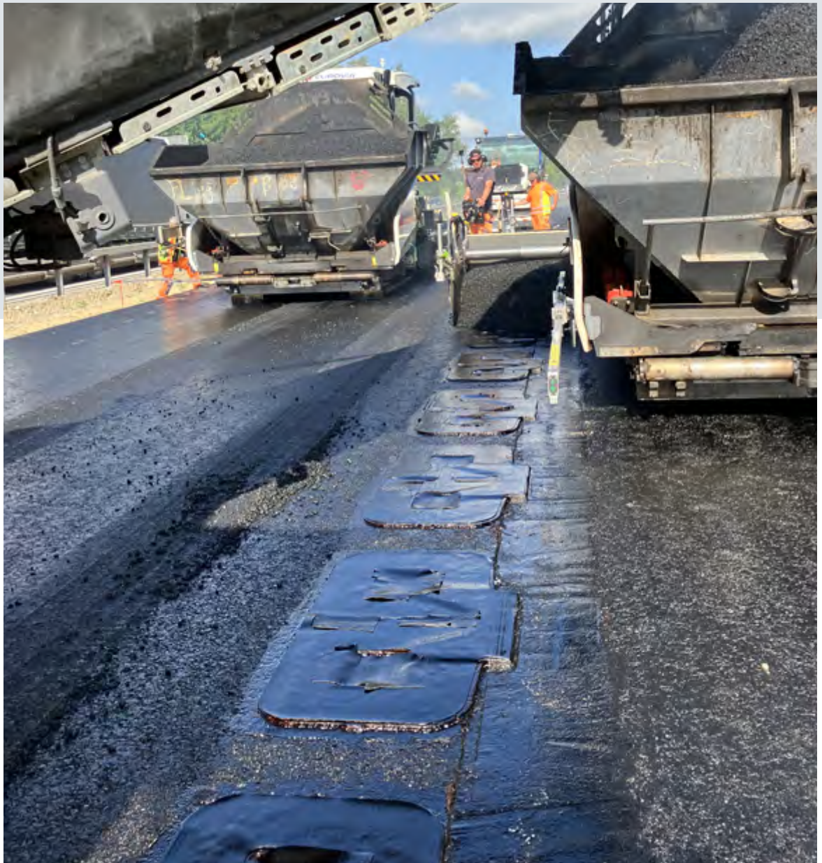
Einbau Asphaltbinderschicht
