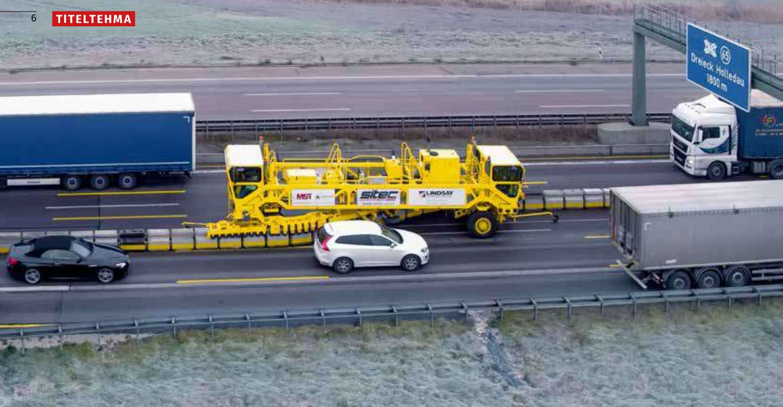
Umsetzen der QMB-Wand mit dem Road Zipper im fließenden Verkehr
