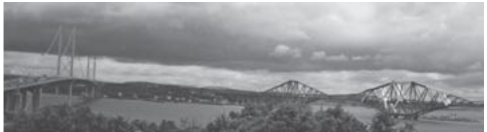
Blick auf die Forth Road Bridge (links) und Eisenbahnbrücke Forth Bridge (rechts)
