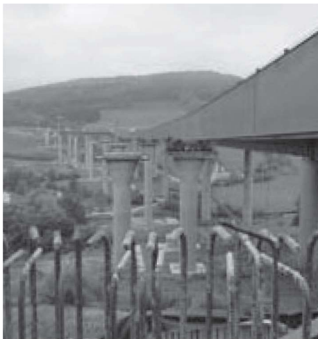
Die neue Sinnthalbrücke wächst kontinuierlich
