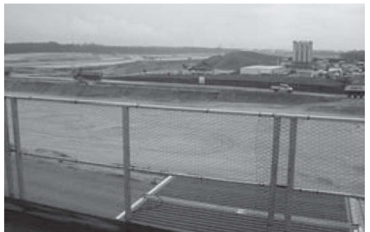
Betonfahrbahn Landebahn Nordwest mit örtlicher Mischanlage
