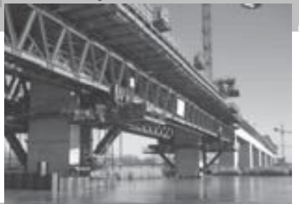
Saale-Elster-Talbrücke, NBS Erfurt - Leipzig/Halle Bautechnische Prüfung
