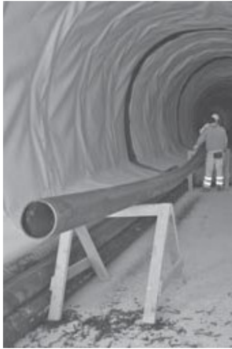
Abdichtungsarbeiten am Rettungsstollen des Tunnels Deschelberg
