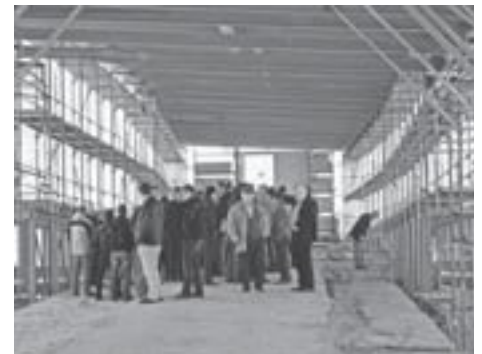
Steinerne Brücke im Bauzustand
