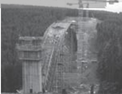
Neubau EÜ Massetal, NBS Erfurt - Ebensfeld Bautechnische Prüfung
