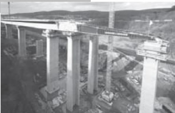
Neubau der Kauppentalbrücke, BAB A3 Bautechnische Prüfung
