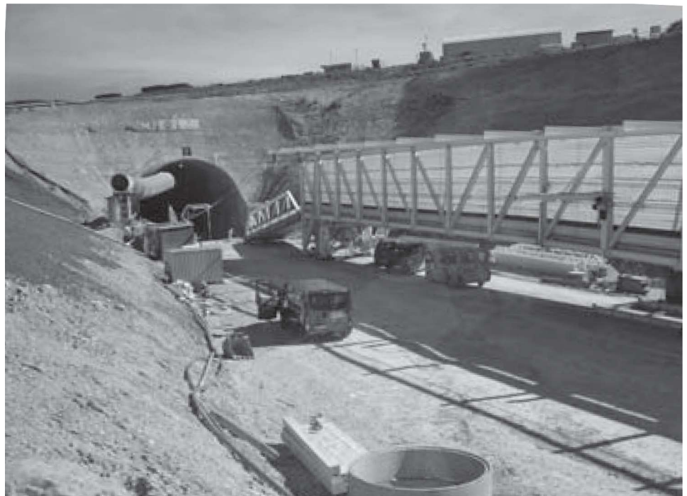
Sohlbrücke vor ihrem Einsatz im Tunnel Reitersberg
