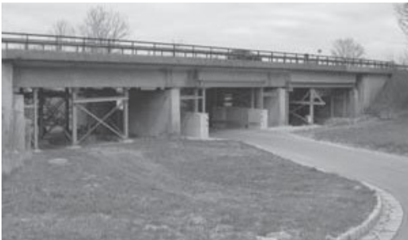
Provisorisch unterstützte Brücke über den Fuchssteiggraben und die Verkehrsbeschränkungen auf der A8 in der Nähe der AS Neukirchen (Landkreis Berchtesgadener Land) – Ein Beispiel für den schlechten Zustand von Brücken im Zuge der A8 Rosenheim - Salzburg
