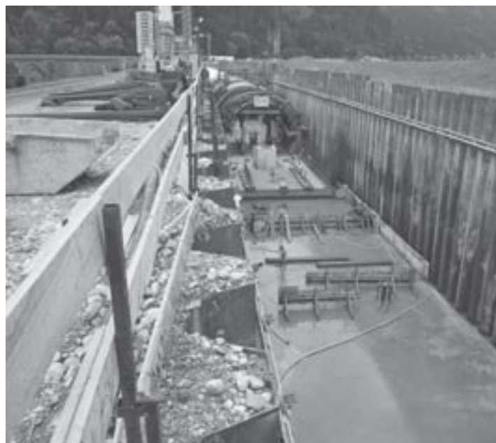
Offene Tunnelbaustelle der ÖBB bei Radfeld
