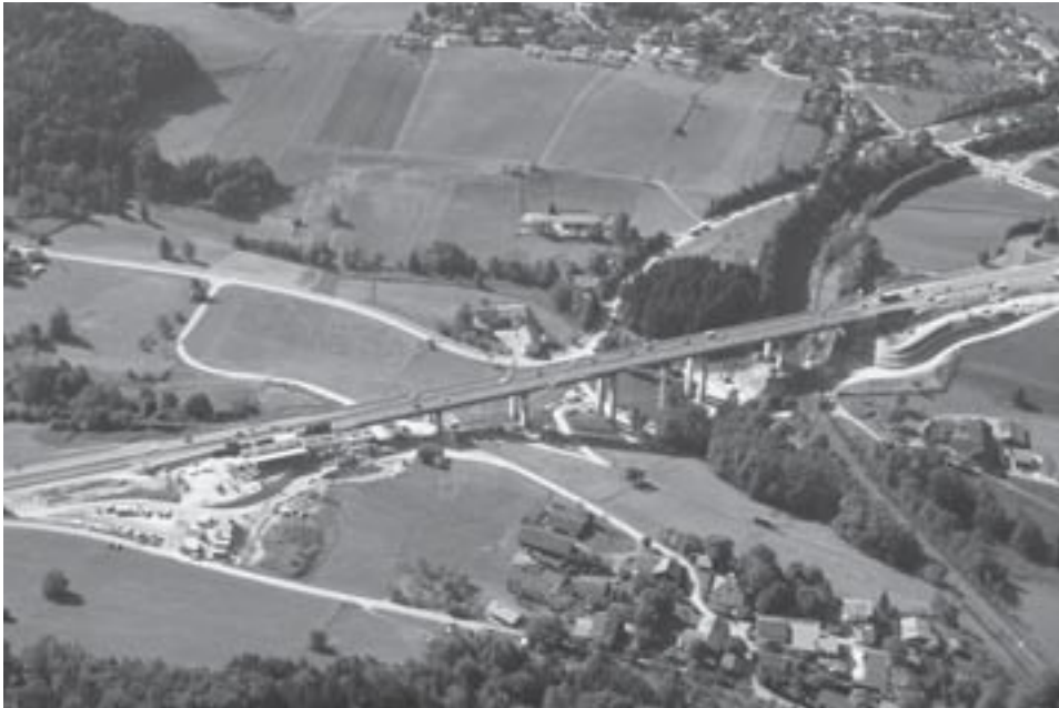
Neubau der 345 m langen Talbrücke bei Bergen (Landkreis Traunstein) – Eine Maßnahme, die wegen des schlechten baulichen Zustandes der Brücke noch vor dem 6-streifigen Ausbau erfolgen muss; Bauziel: 2014
