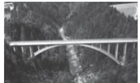
Mittels eines Wettbewerbs wird ein Konzept für den Neubau der Echelsbacher Brücke gesucht.
