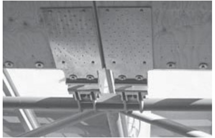
Anschlussdetail im Werkhof Hohenems
