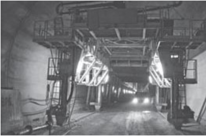
Einbau der Zwischendecke im Tunnel
