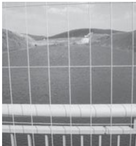
Kein Rückhaltebecken, sondern eine Erdbaustelle im Zuge einer Zubringerstraße zur B 50neu
