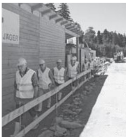
Baustellenbesichtigung des Deschlbergtunnels
