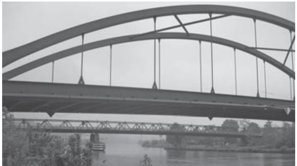
Neue Mainbrücke Segnitz, im Hintergrund das alte Bauwerk
