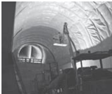
Querschlag zur Entlüftung
