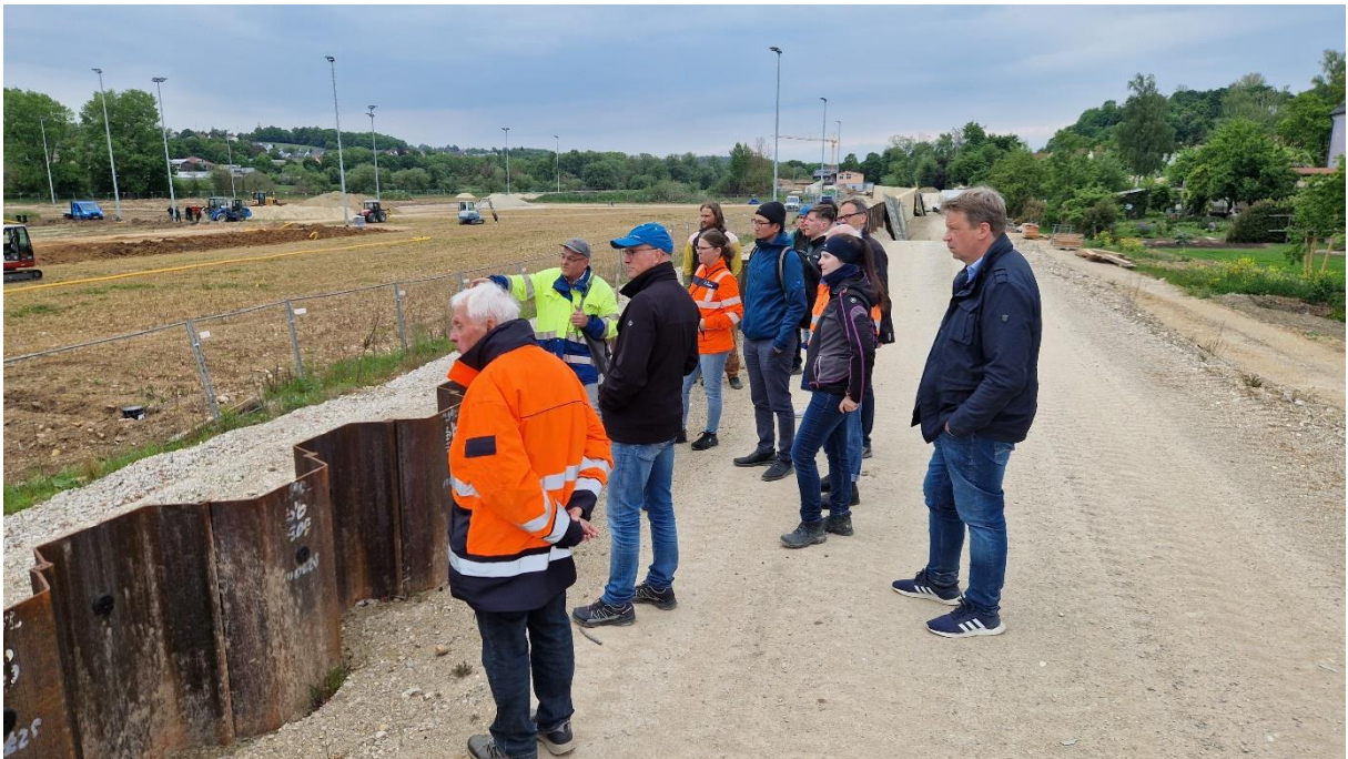
Baustelle zum Hochwasserschutz Regensburg Abschnitt E, Sallern
