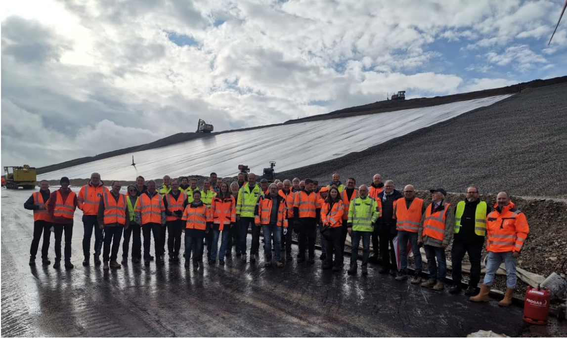
Gruppe beim Einbaubereich der Asphaltabdichtung Foto: Andreas Appelt
